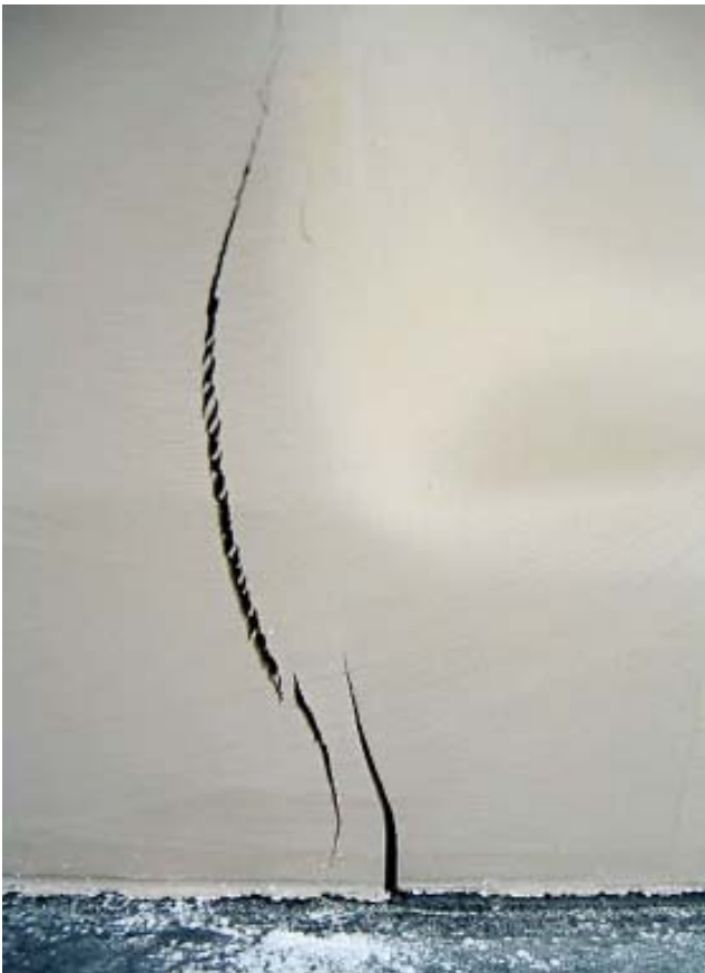
แผลแตกที่เกิดจาก น้ำหนักชั้นงานกดลงบนฐาน
